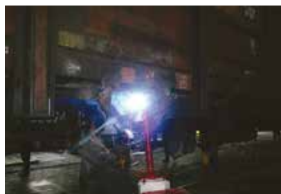
Поджатие дефектного места и проведение сварочных работ
