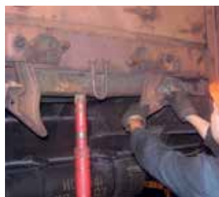
Поджатие люка и вставка уравнивающих прокладок
