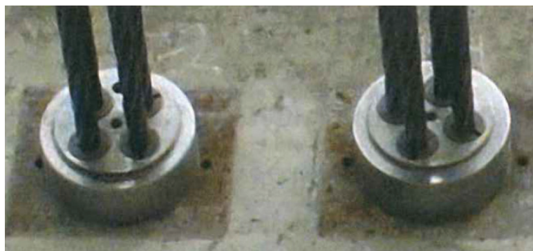
Установка обоймы анкера
