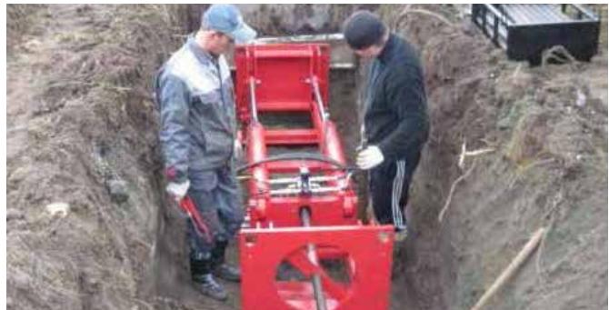
ком. Затем в приемном котловане надевается специальный нож-расширител, который, при обратном протягивании, продольно разрезает данный участок трубы с расширением или без него. При этом остатки старой трубы вдавливаются в грунт, а скважина расширяется до диаметра новой трубы. За расширителем устанавливается специальный захват, с помощью которого протягивается новая труба.
