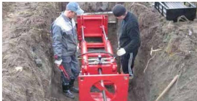
ком. Затем в приемном котловане надевается специальный нож-расширитель, который, при обратном протягивании, продольно разрезает данный участок трубы с расширением или без него. При этом остатки старой трубы вдавливаются в грунт, а скважина расширяется до диаметра новой трубы. За расширителем устанавливается специальный захват, с помощью которого протягивается новая труба.
