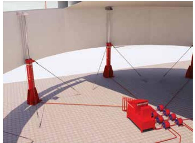
нения метода «подращивания», следует отнести выполнение основной части работ на уровне земли, что обеспечивает повышение производительности труда, качества работ, улучшение условий труда и безопасность производства работ. Этот метод пригоден для сооружения резервуаров практически любой вместимости.
